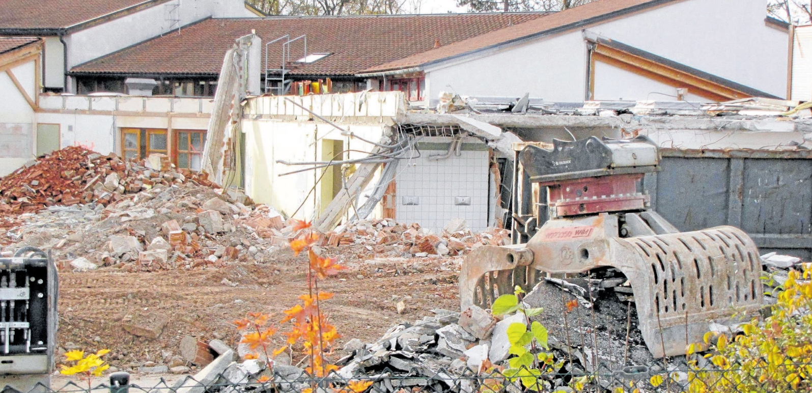
Die Abbrucharbeiten im östlichen Teil der Elisabethschule in Aichach sind fast abgeschlossen. Bis zum Schuljahr 2025 wird auf dem Gelände ein moderner, dreigeschossiger Erweiterungsbau entstehen. Die Kosten: rund 19 Millionen Euro. Foto: Robert Edler
